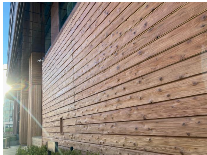
ObiRED®+凸凹Gywood®+AZN（水性シリコン系塗装） 節有材を活用した凸凹により、美しい陰影が生じる
