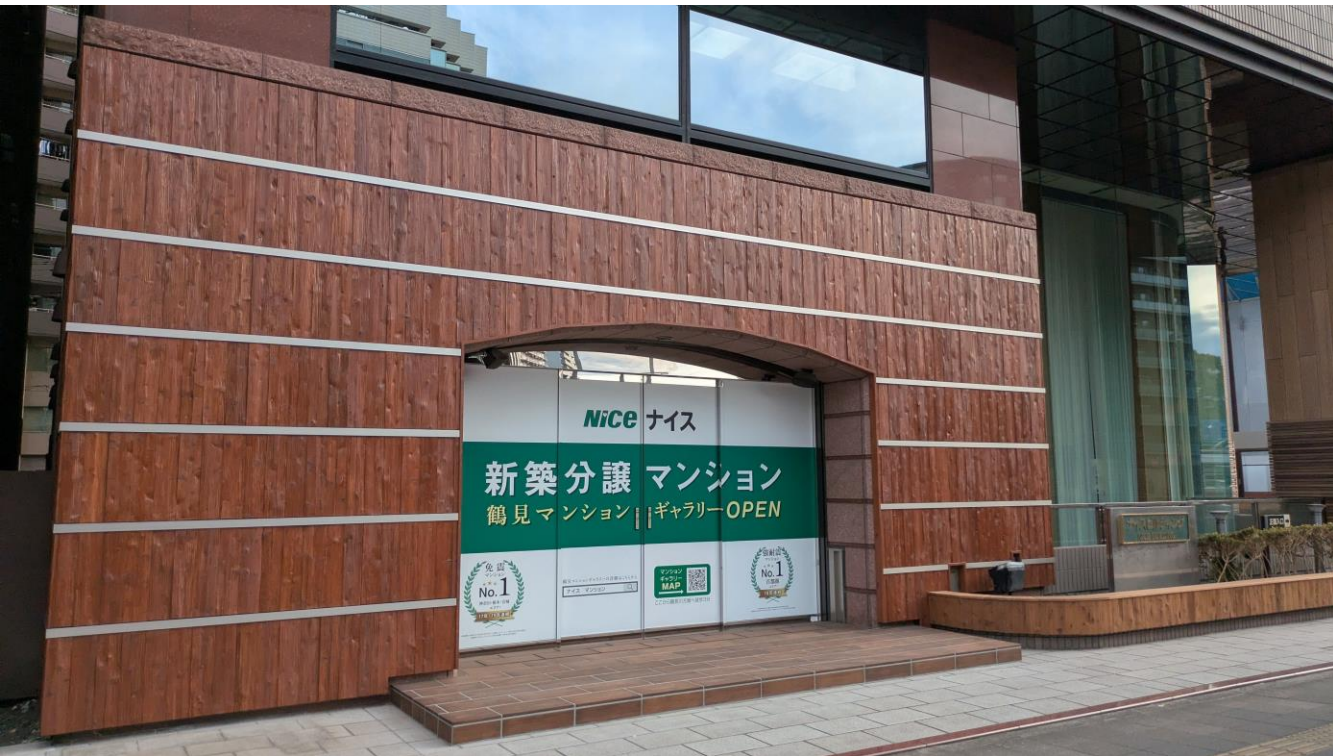
壁：ObiRED®+芯込凸凹Gywood®+AZN（油性含侵系塗装） 節有材・芯込材を活用した凸凹により、木の存在感を強調する
