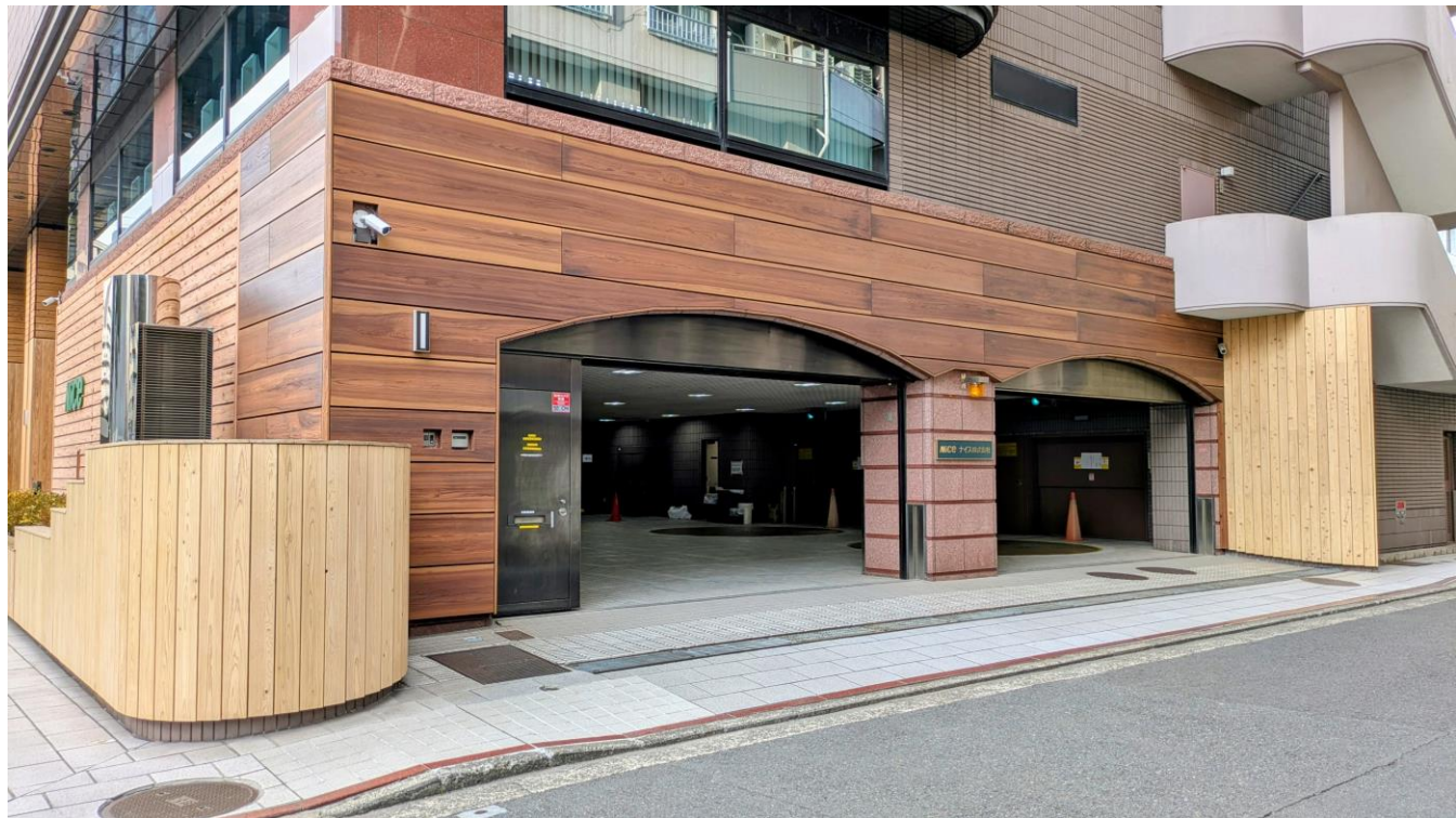
腰壁：ヒノキ+Gywood®+AZN （水性アクリル系塗装）
