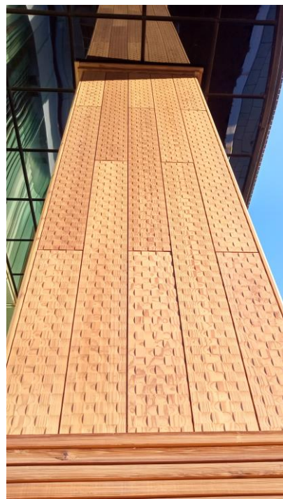
左：ObiRED®+スーパーGywood™+NC加工+AZN 中：アカマツ+スーパーGywood™+NC加工+AZN 右：スギ赤身芯去正角材+スーパーGywood™+AZN
