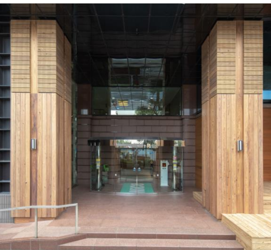
ObiRED®+Gywood®+AZN（油性含侵系塗装） 柱上部にはスリット加工材を使用
