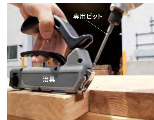
治具で固定しビスをセット。 ガイドに沿って打ち込みます。
