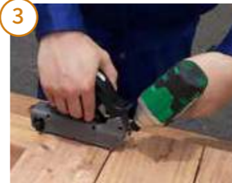
専用ビットでビス固定
