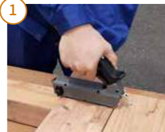
デッキ材に治具をセット
