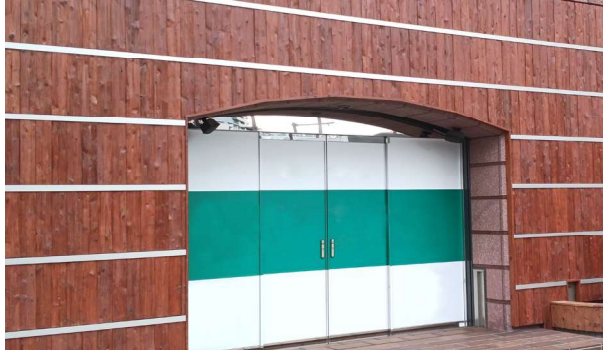
凸凹Gywood®に油性含侵系着色塗装によって外装材に使用した例。
