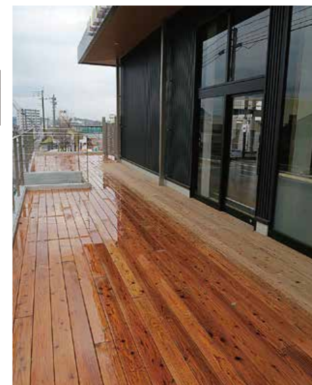
鹿屋女子高等学校 多目的ホール棟デッキ
